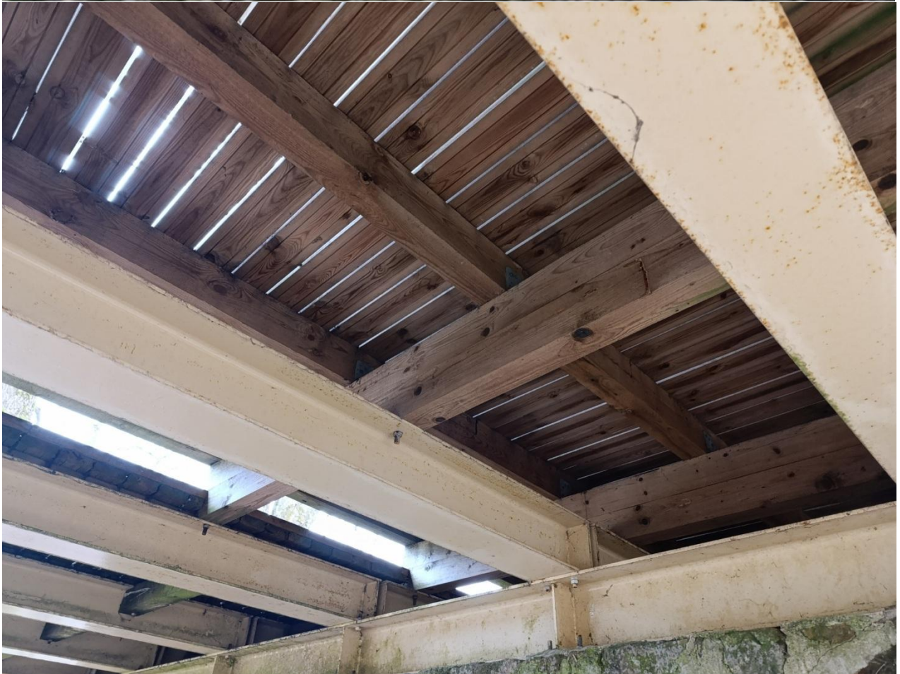
Statinio (apžvalgos tilto) paliekamų plieninių konstrukcijų esama būklė
